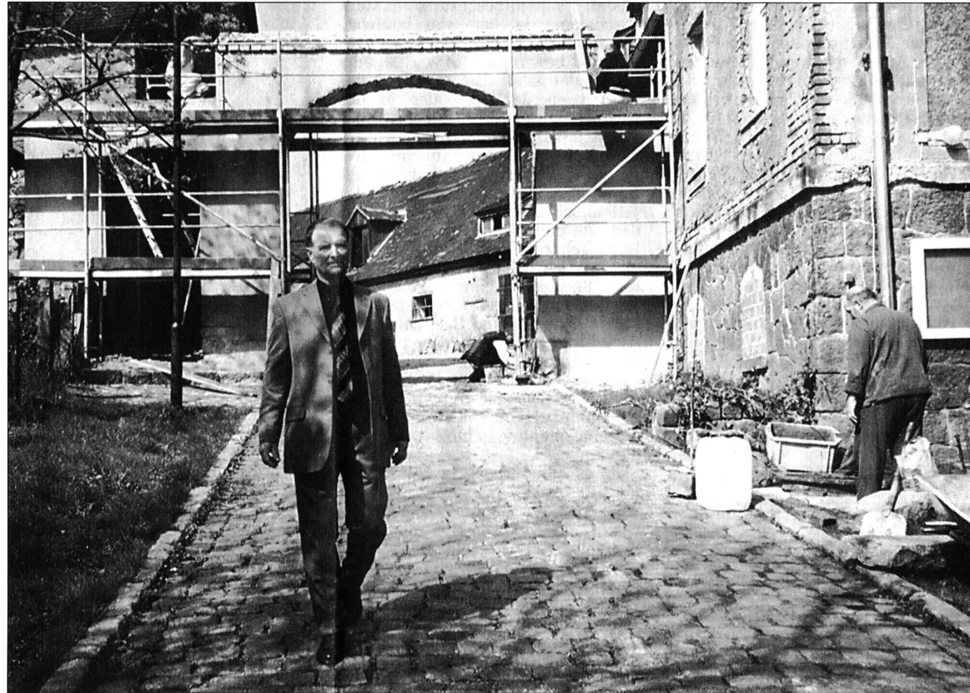
Prof. Dieter Nadolski vor der Schlossanlage in Taucha. Tor und Torbogen werden derzeit saniert.
